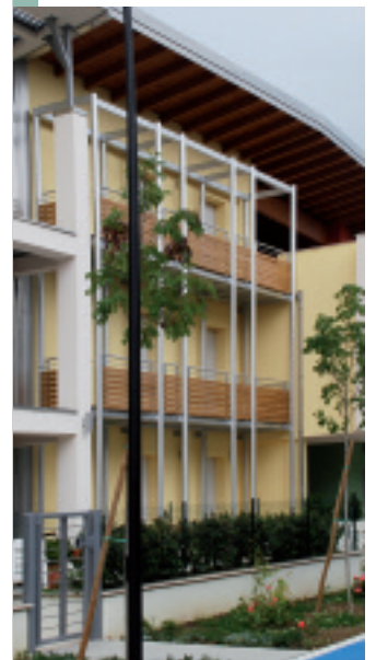
Fig. 13 - Prospetto sud edificio "Ab2" (14 alloggi)
