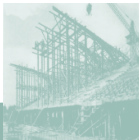
Fig. 4 - Ponteggio per la costruzione dei mensoloni della tribuna coperta
