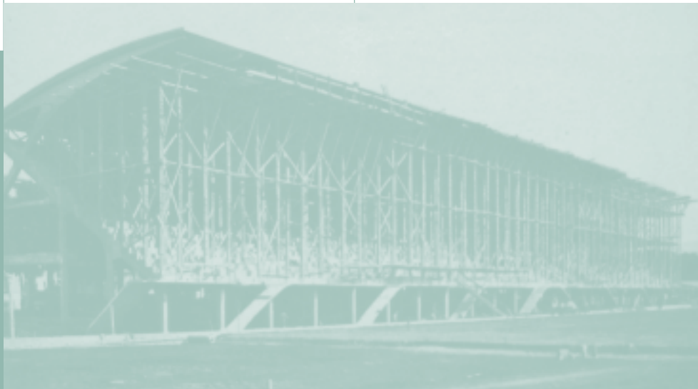
Fig. 17 - Ponteggio per la realizzazione della pensilina della tribuna coperta
