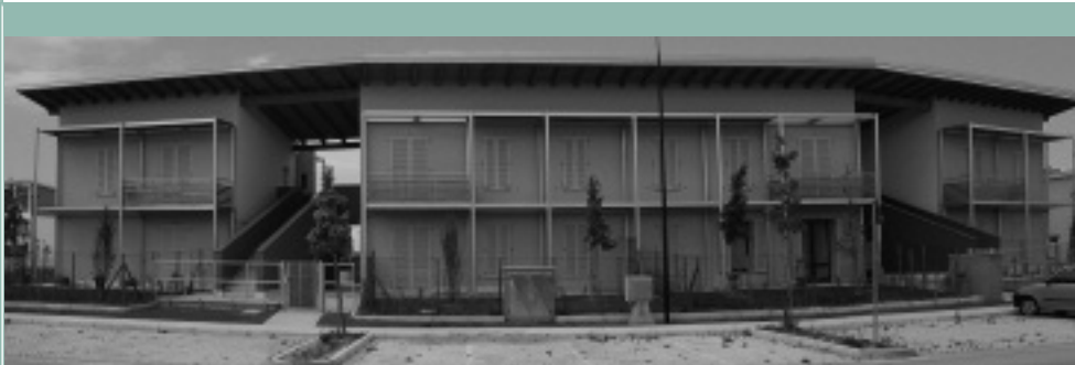
Fig. 7 - Prospetto sud-ovest, edificio "Ag1" (8 alloggi)
