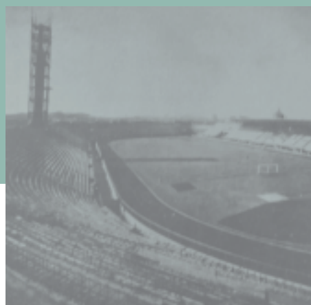
Fig. 5 - Ponteggi per la realizzazione della Torre Maratona
