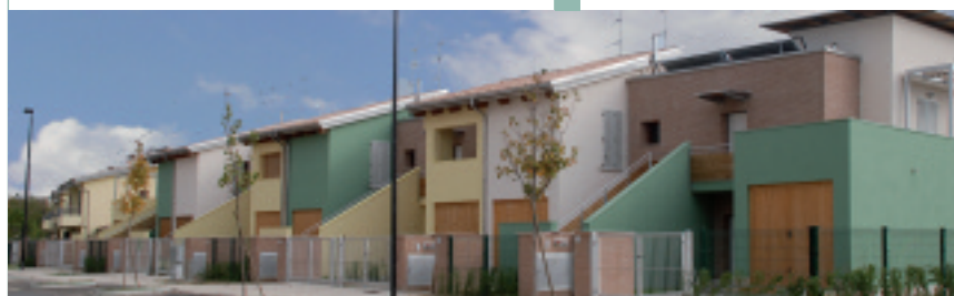
Fig. 10 - Prospetto nord edificio "Ad2" (8 alloggi a schiera)
