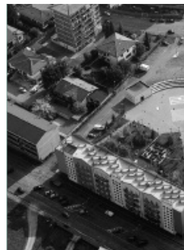
Fig. 2 - Italia- Alessandria- 2000 Riqualificazione energetica di 200 alloggi di edilizia sociale soggetto promotore: Comune di Alessandria
