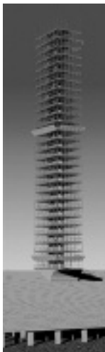
Fig. 13- Ponteggio a tubi e giunti per la costruzione della Torre Maratona
