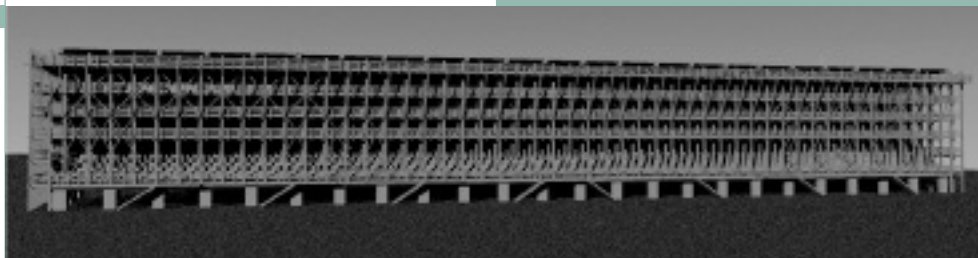
Fig. 19 - Ricostruzione grafica del ponteggio messo in sicurezza
